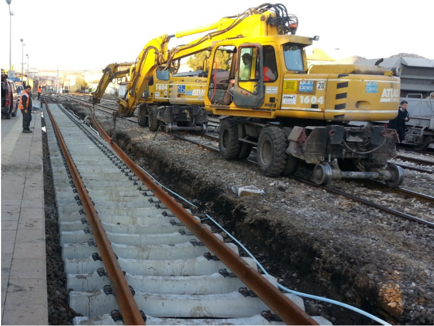
Vagon Çekme – Ray Yerleştirme
